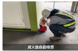
滅火器自動檢查
